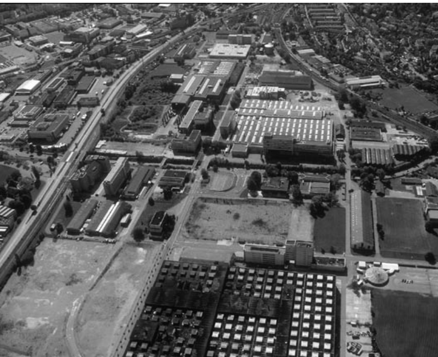
Secteur industriel Sulzer à Winterthur: réaffectation d'une ancienne usine
