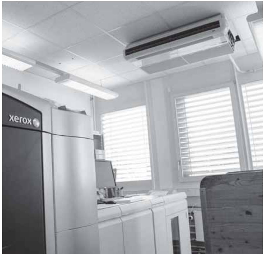
Macchina da stampa digitale e, al soffitto, un climatizzatore alimentato con il calore residuo delle stampatrici.
