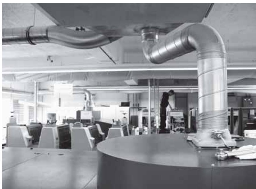
Die Abwärme des Trockners wird zum Wärmetauscher geführt und genutzt.
