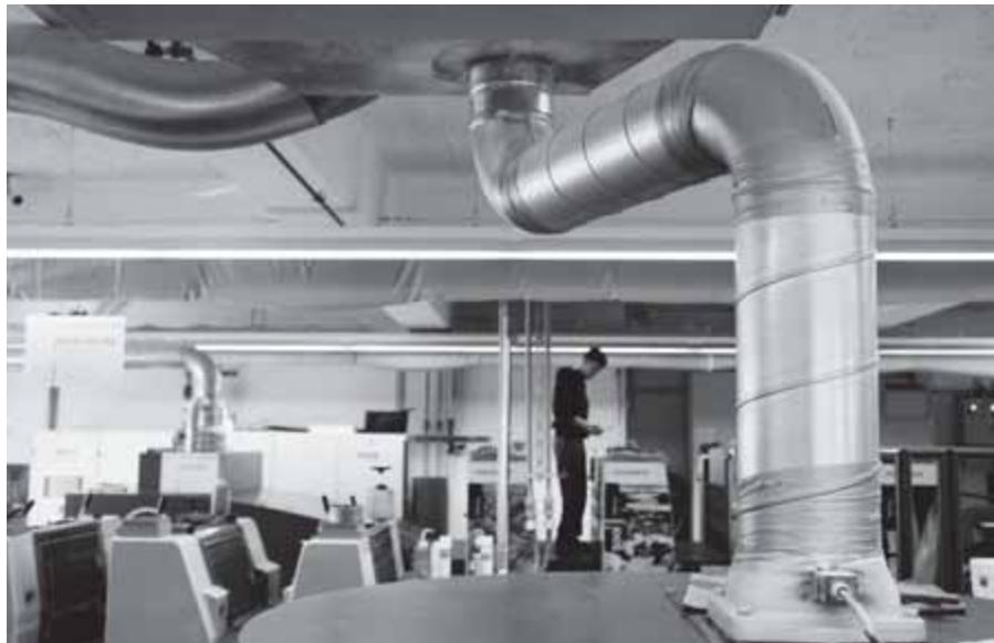
Il calore residuo dell'impianto di asciugatura è convogliato verso lo scambiatore di calore e quindi utilizzato.
