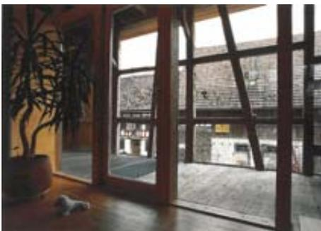
*Ein Haus im Haus: Losgelöst von der alten Raumstruktur wurden autonome Raumkuben aneinander und aufeinander gefügt. Die Zwischenzone, innerhalb der bestehenden Raumhülle, bietet Aussenräume (Balkone) für das Einfamilienhaus. Die Aussenschalung kann als Schiebetore verschoben werden.*
