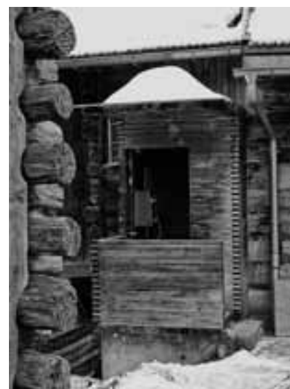
Cabina telefonica a Vrin, architetto: Gion A. Caminada (photo: Lukas Kistler, 2011)
