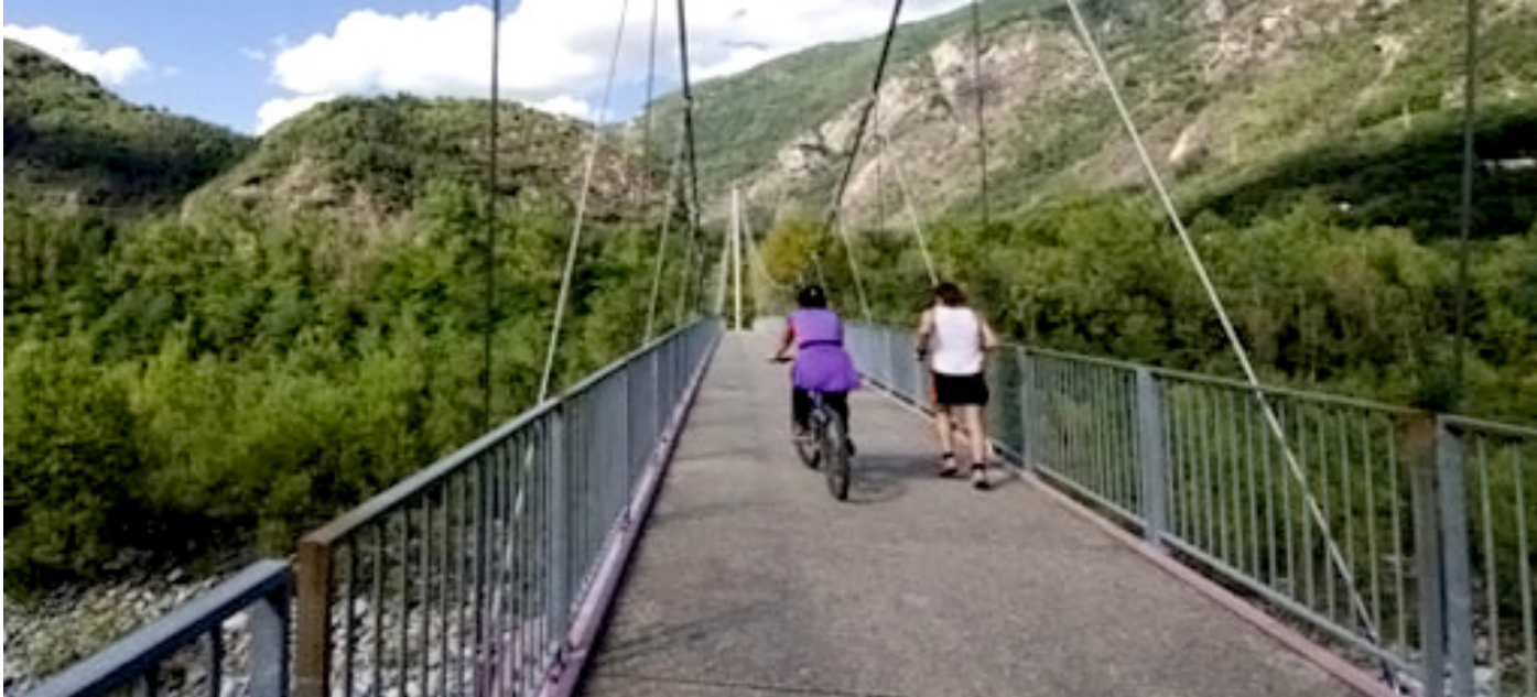
Illustration 7 – Dans l’agglomération de Locarno, le delta de la Maggia est un important espace de détente de proximité à revaloriser.
