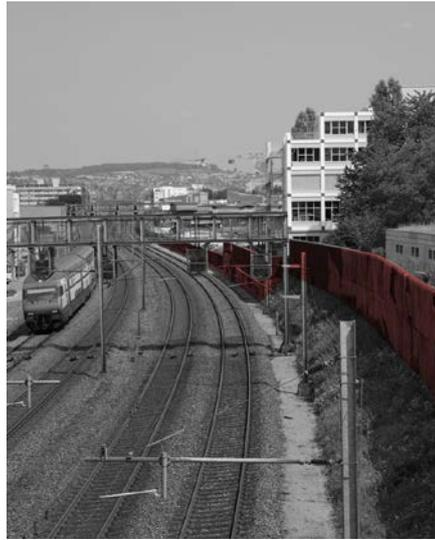
**Figure 7: Combinaison avec la protection contre le bruit**
