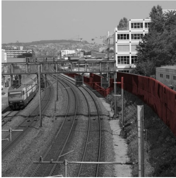
Figure 7: Talus de protection végétalisé combiné avec un mur anti-bruit
