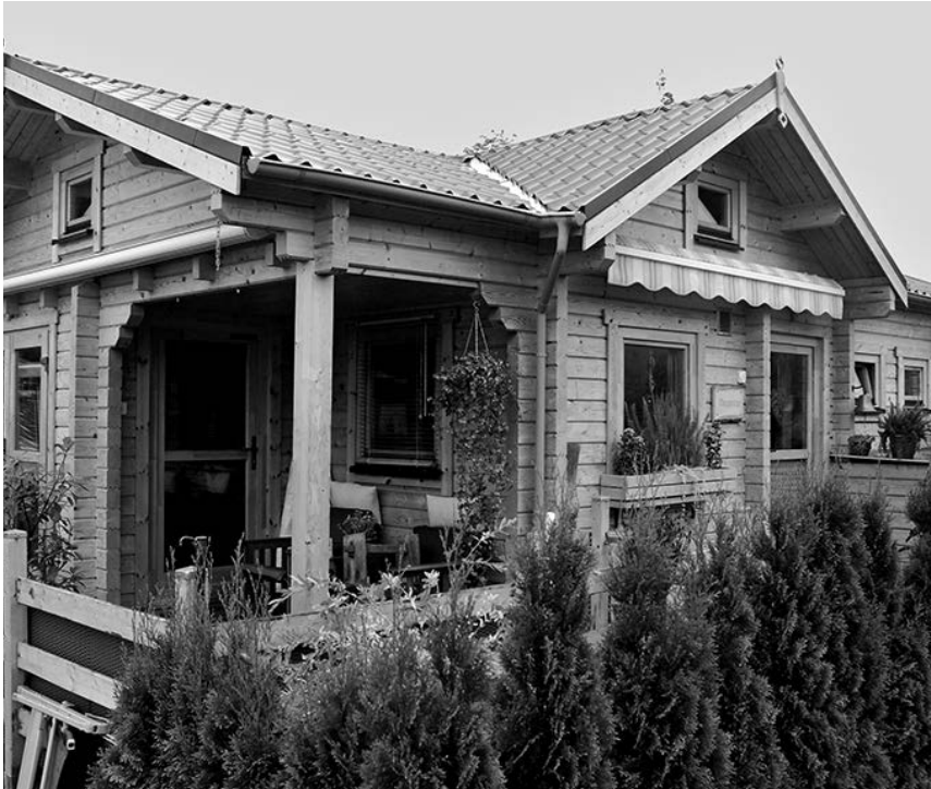
Un progetto a lungo termine: la Bergshütte, una casa svedese in tronchi d'albero realizzata su una fondazione continua
