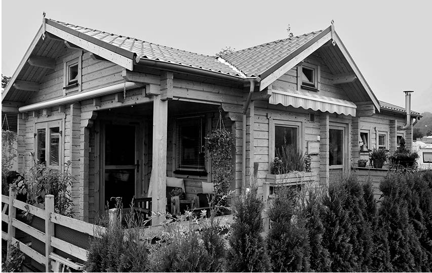
Ein langfristiges Projekt: die Bergshütte, ein schwedisches Blockhaus mit Streifenfundament.
