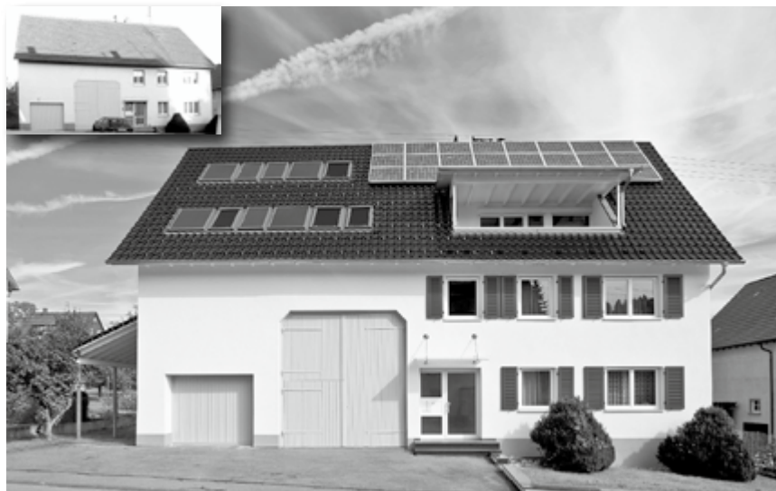
Energetische Sanierung eines Eindachhofes in D-72364 Obernheim, Baden-Württemberg: Der für Obernheim typische Eindachhof wurde nicht mehr landwirtschaftlich genutzt und zu einem reinen Wohnhaus umgebaut. Dabei wurde eine umfassende energetische Sanierung mit Vollwärmeschutz, Brennwerttechnik, Solarthermie und Photovoltaik umgesetzt. Architekt: Friedrich Rau, Albstadt, Baden-Württemberg.
