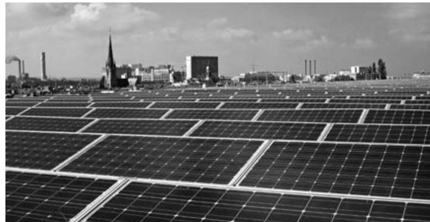
Le toit de la halle 1 de la foire de Bâle est entièrement recouvert de panneaux photovoltaïques (photo mise à disposition)
