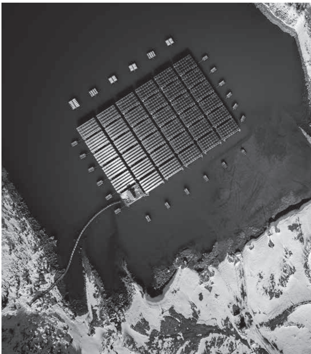
L'impianto pilota sul bacino artificiale del Lac des Toules, a oltre 1800 m s.l.m., è attivo dal 2019.
