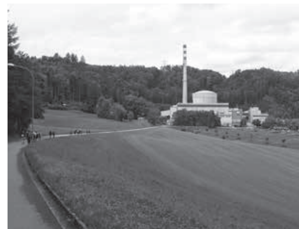
Das AKW Mühleberg wird derzeit rückgebaut.
