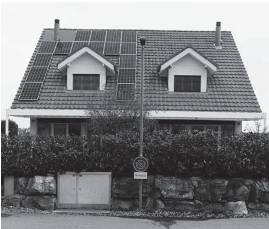
Solardach in Belp bei Bern.
