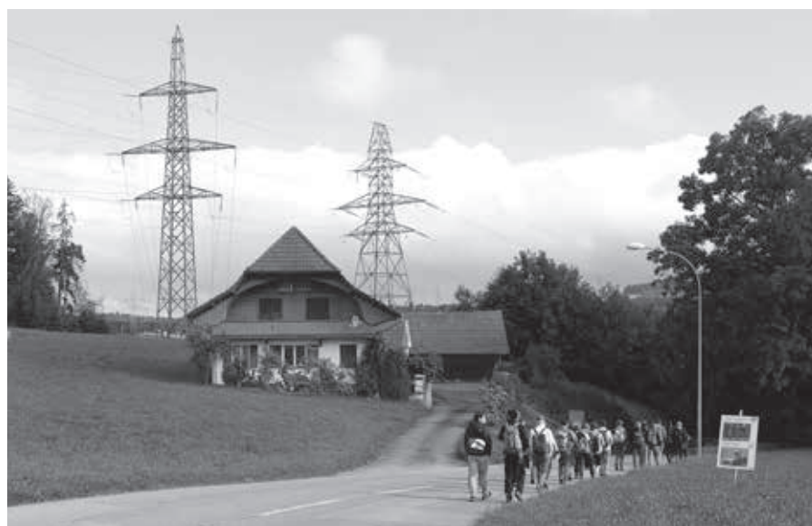
Paysage marqué par l'énergie à proximité de la centrale nucléaire de Mühleberg.
