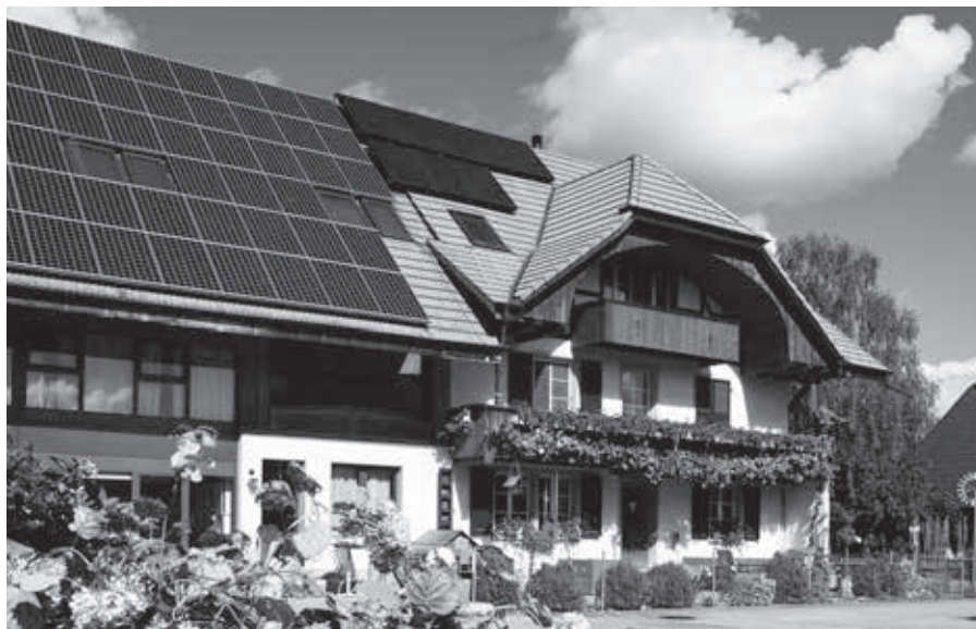
Presso Beerenland, l'energia solare proveniente dal tetto viene già oggi utilizzata per gli impianti di raffreddamento e per gli alloggi del personale.
