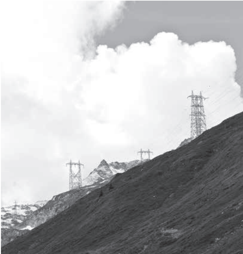
Lignes à haute tension traversant les Alpes près du col du Nufenen.
