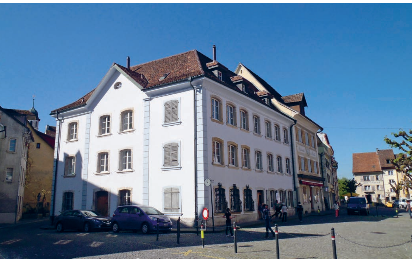
▣ Bâtiment ayant bénéficié d'un assainissement dans le centre historique de Porrentruy
