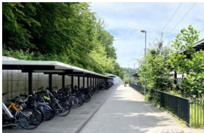
Illustration 2: Abri B+R à proximité de la voie en direction de Aarau/Olten (Source: Forum vélostations Suisse).
