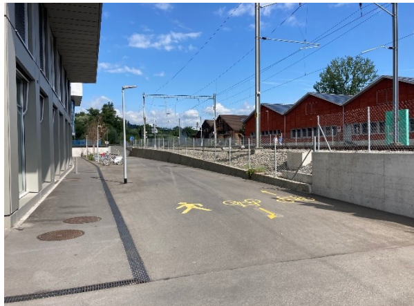
Figure 35 : Raccordement à la Freigleis .
