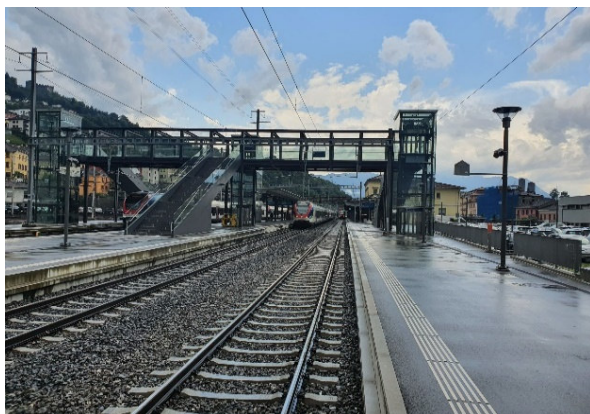
Figure 10 : Nouveau passage surélevé au nord de la gare de Bellinzona, source: photo propre
