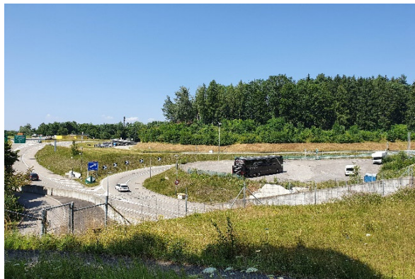
Figure 38 : Sortie d'autoroute Neufeld et Car Terminal, source : photo propre
