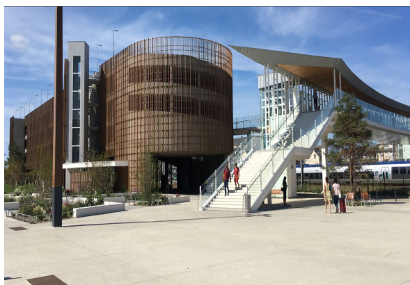
Figure 47 : Parvis sud du parking couvert et passerelle de la gare de Saint-Brieuc, source : www.cerema.fr
