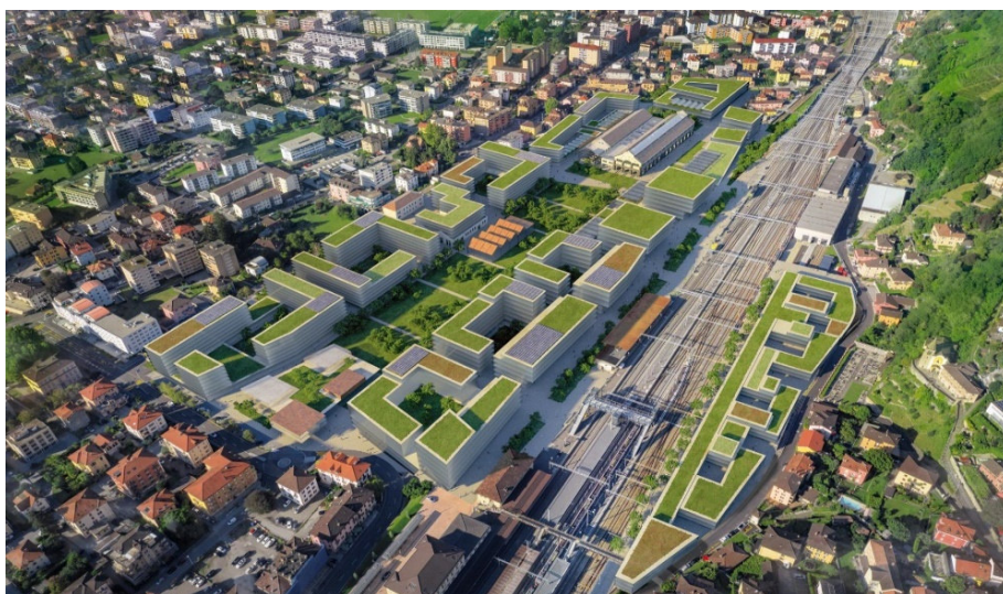
Fig. 14 – Nuovo quartiere presso la stazione di Bellinzona (visualizzazione), fonte: https://www.quartiereofficine.ch/
