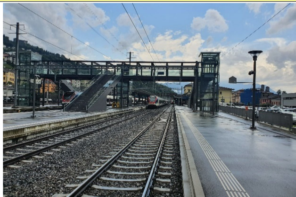
Fig. 10 – Nuova passerella pedonale a nord della stazione, fonte: immagine propria
