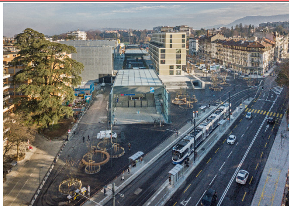
Fig. 29 – Stazione di Ginevra-Eaux-Vives, fonte: www.ceva.ch > Chantiers > Genève - Eaux-Vives.
