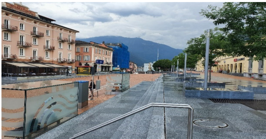
Fig. 13 – Nuovo piazzale della stazione di Bellinzona, fonte: immagine propria
