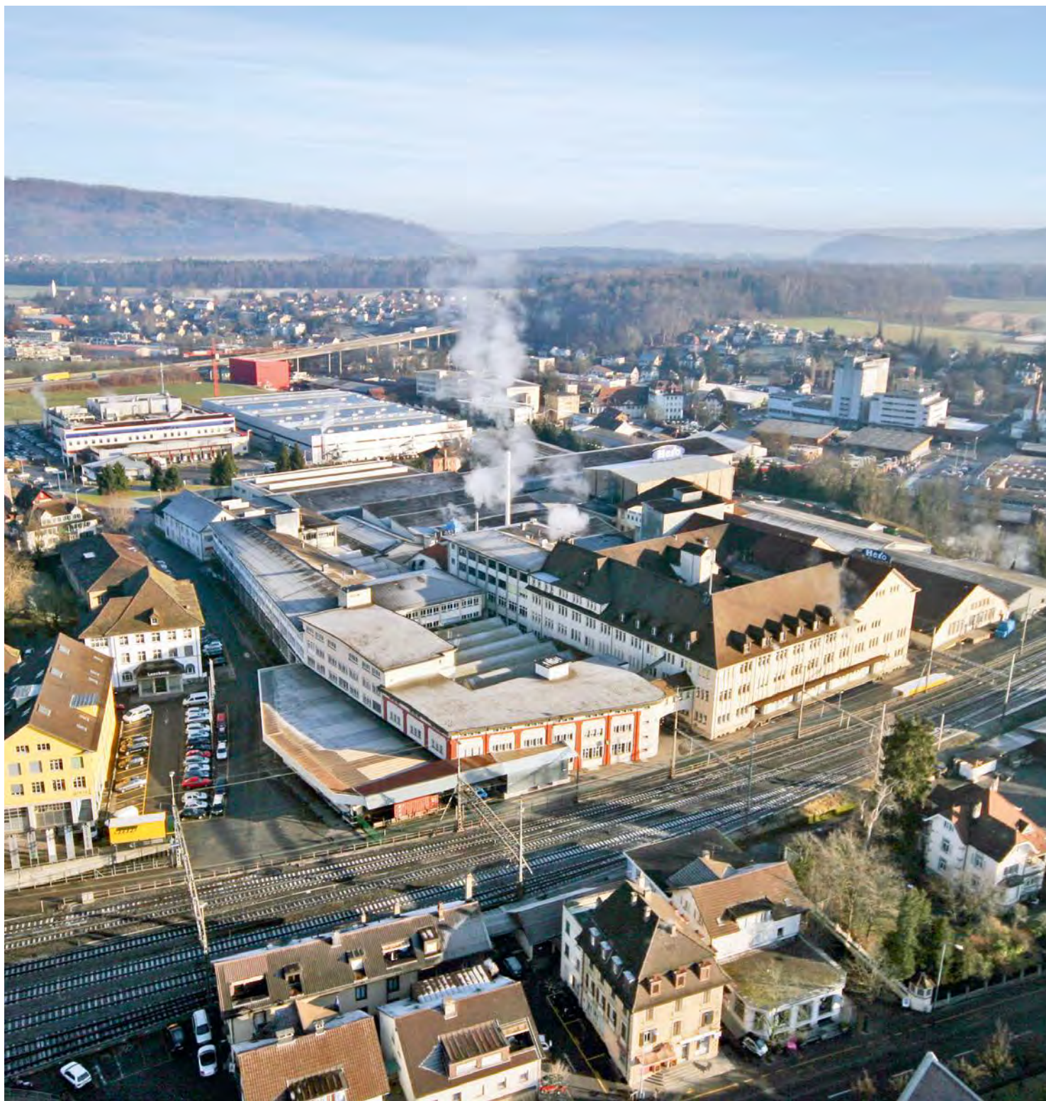
La fabbrica di conserve Hero lascerà il posto a un nuovo quartiere abitativo e lavorativo, progettato secondo i principi dello sviluppo sostenibile. I lavori di costruzione sono tuttora in corso. (Foto: Losinger Marazzi AG)
