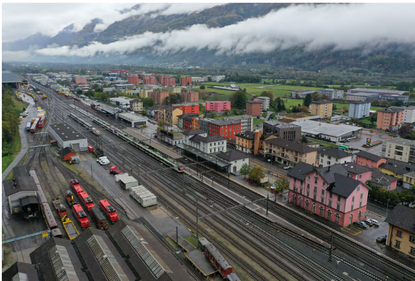
Figura 12: Comparto della stazione di Biasca. (Fonte: ARE, monitoraggio fotografico «Bildmonitoring»)
