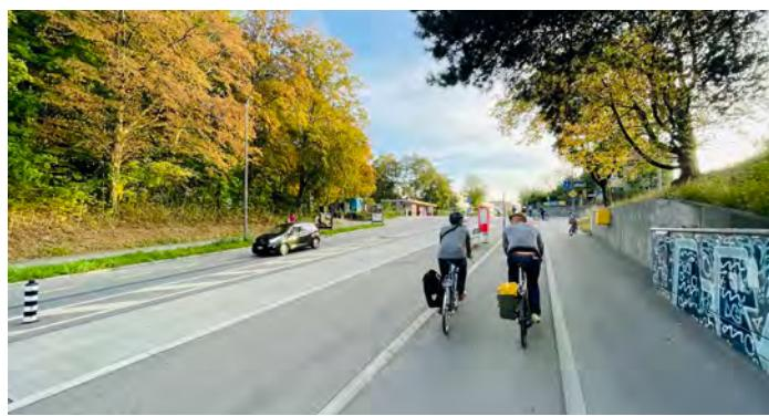
Presso la fermata dell'autobus «Dübystrasse», la struttura della pista ciclabile permette ai ciclisti di attraversare la zona della fermata senza entrare in conflitto con i pedoni. Il tracciato è sufficientemente largo per consentire ai ciclisti più veloci su questa strada in pendenza di superare quelli più lenti.
